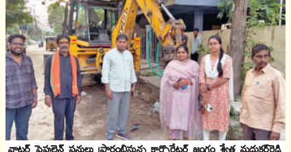
నాథన్ పైపులైన్ పనుల ప్రారంభిస్తున్న కార్పొరేటర్ జంగం శ్వేత మధుకరరెడ్డి
